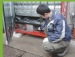
コンプレッサー清掃
